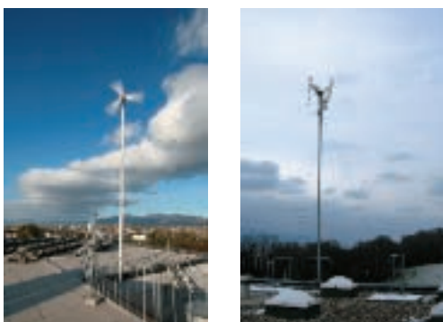
Les deux éoliennes en activité sur le toit de la HEIG-VD depuis l'automne 2009.
