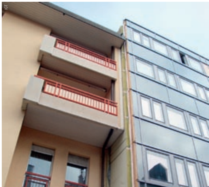
Bâtiment au standard Minergie-P avec la partie droite rénovée. Ce projet est chapeauté par l'IGT sur mandat de l'Office Fédéral de l'Énergie.
