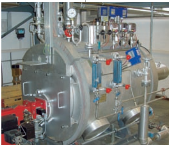
Chaudière à vapeur saturée utilisée dans le cadre de cours pour le personnel de chaufferie et pour l'obtention du brevet fédéral de thermiste.
